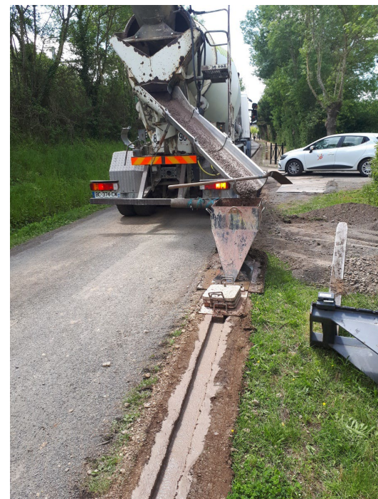
Installation de la fibre
