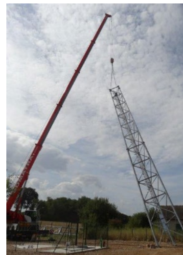
Nouveau pylône en cours de levage à Egreville (77) pour un opérateur
