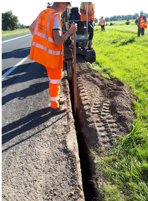
Enfouissement des câbles
