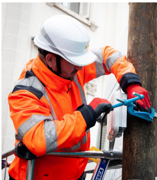
Tirage aérien de la fibre par un raccordeur de fibre
