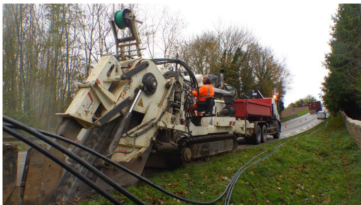
Travaux de tranchée pour la pose des fourreaux nécessaires au transport et à la distribution.
